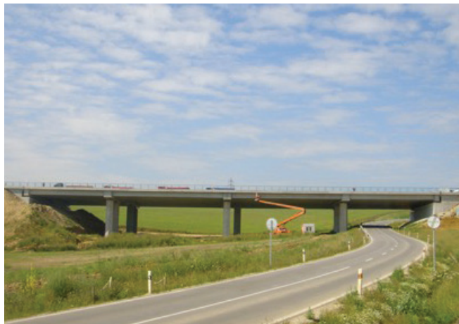
Výstavba Rýchlostnej cesty R1 Nitra
